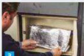
3 Presione sobre el velcro ajustándola a la forma del contador
