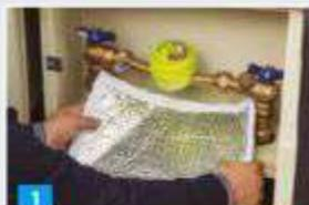
1 Coja su lámina aislante por la cara en la que va el velcro adherido
