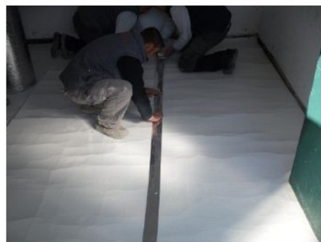
Encintar con Polyfix, la unión de Polynum BLH
