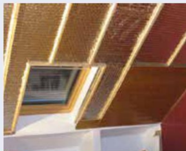
1 Techos y buhardillas
