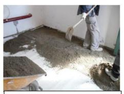
Poner sobre rejilla de mallazo sobre el mortero existente.
