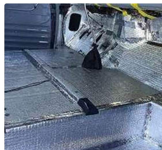
Aislamiento zonas críticas
